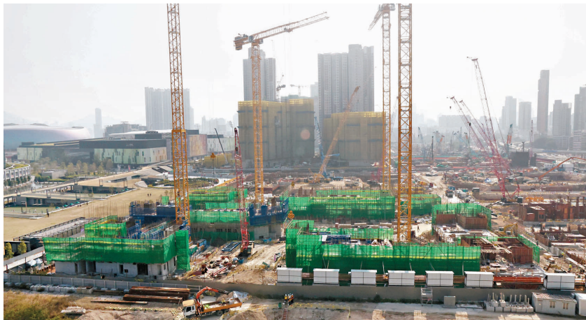
●近年香港在建屋方面提速提量，公屋供應量大幅提升，圖為啟德世運道一號興建中的簡約公屋地盤。資料圖片
