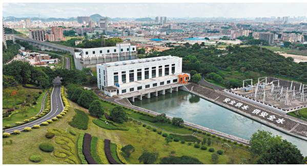
●金湖渡槽是東改工程最長的渡槽，是同期同類型世界最大的現澆預應力混凝土U型薄殼渡槽。深圳特區報苗威攝
