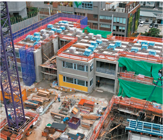
◀現時已有逾100個政府及私人項目採用MiC建築法。圖示位於火炭的小學新校舍透過MiC技術建成。
