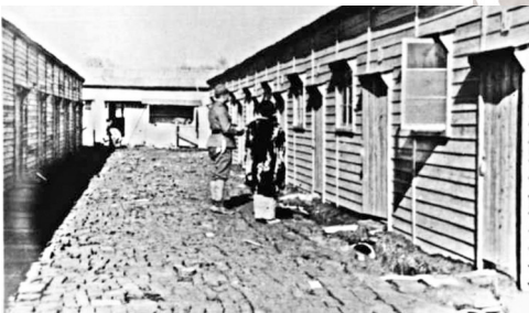
●上海楊家宅慰安所。
