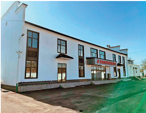
● 葛溝村新建的綜合樓。
