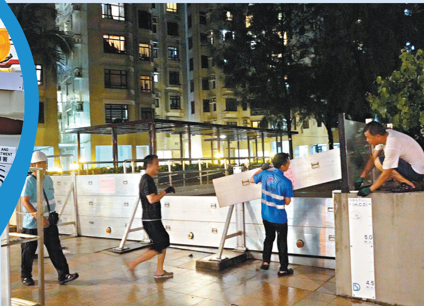
●康文署工人昨晚冒雨在杏花邨海旁安裝防水閘。香港文匯報記者曾興偉 攝
