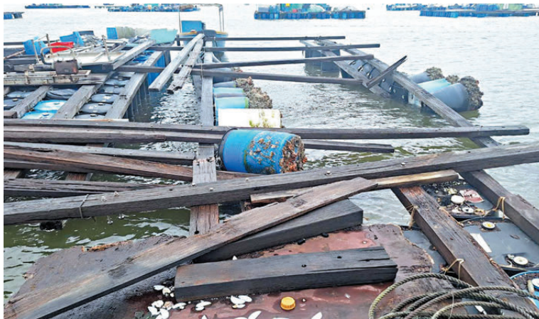
▲魚排受颱風吹襲造成損毀，有膠桶及垃圾堆積。 何俊賢 Fb圖片
