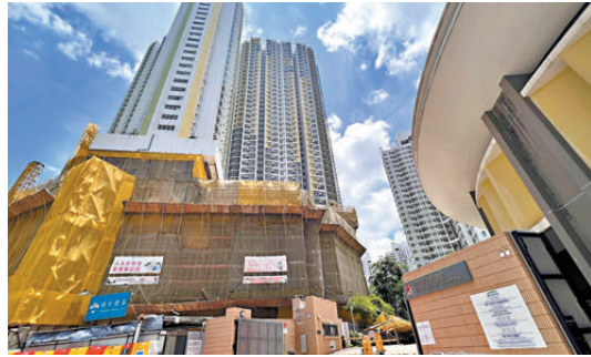
●中海房屋接手滿田邨地盤。
