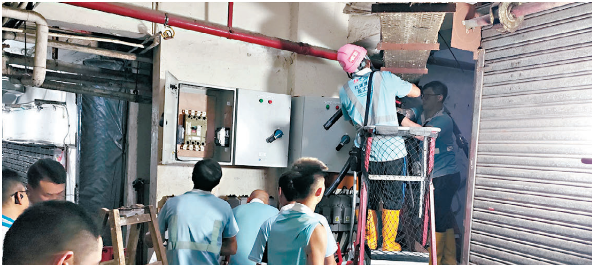
●工程人員努力搶修電力系統。
