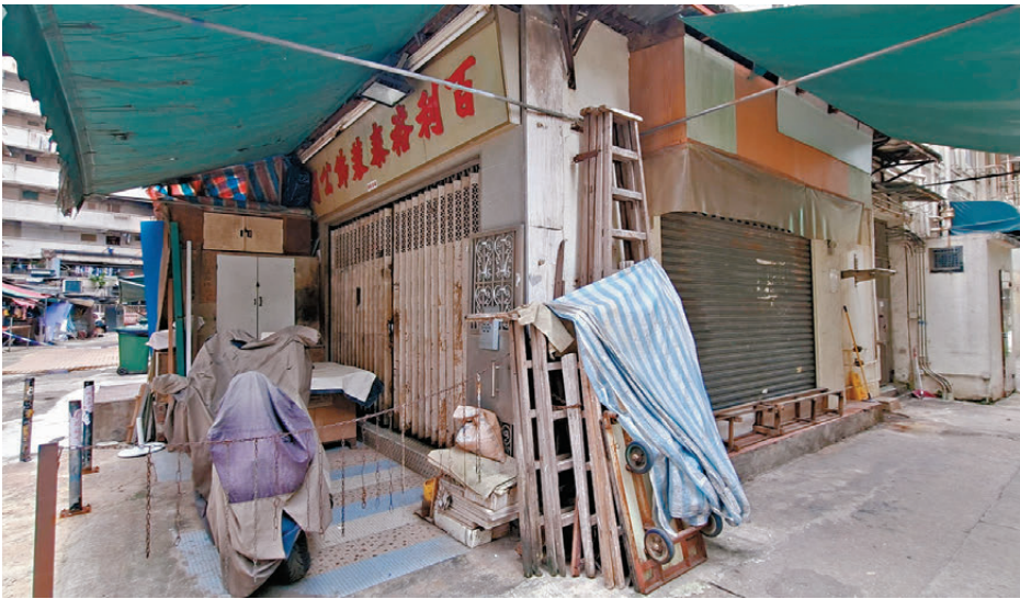
●益豐大廈昨日仍有部分樓層單位及店舖供電不穩，多間店舖暫停營業。 香港文匯報記者鄧偉明 攝
