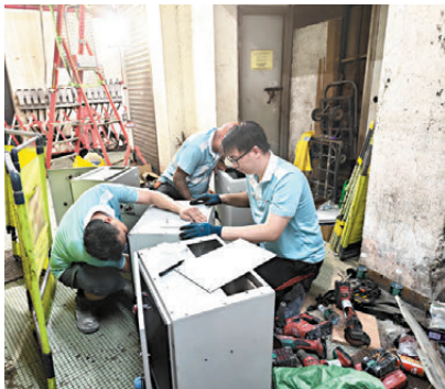
●中建社區應急義工隊展開20小時晝夜搶修攻堅，冀盡快恢復用電。 中建國際供圖
