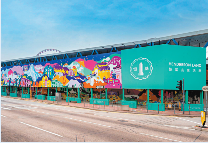
●美國投資管理公司Jane Street早前以約3,061萬元承租中環新海濱三號第一期辦公室及附屬樓面共六層，租賃年期為5年，預計將於2027年交付該公司使用。 資料圖片
