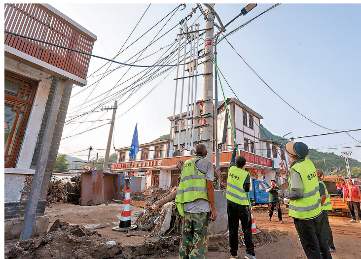
●截至目前，北京受災行政村供電、通信全部恢復，供水問題已全部解決。圖為8月1日，北京市密雲區馮家峪鎮，通信搶修人員架設新的光纖。中新社
