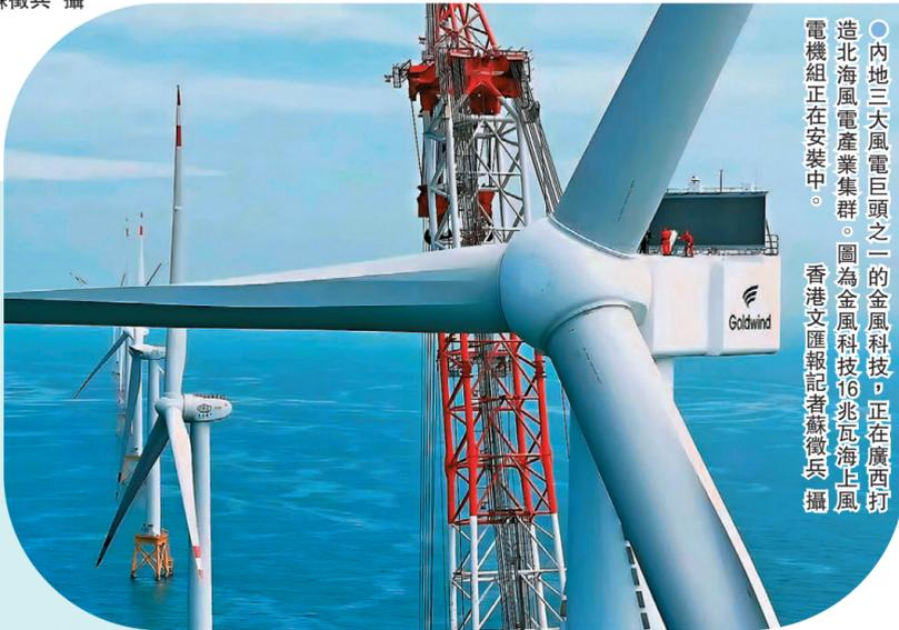
內地三大風電巨頭之一的金風科技，正在廣西打造北海風電產業集群。圖為金風科技16兆瓦海上風電機組正在安裝中。香港文匯報記者蘇徵兵攝
