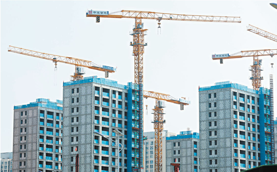
●北京是內地樓市調控政策最嚴格的城市。圖為北京市朝陽區一處在建樓盤。
