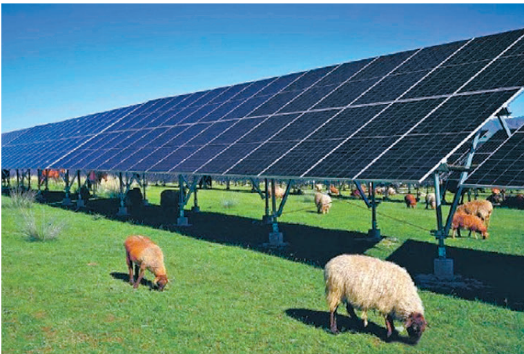
●新疆吉木薩爾縣25萬千瓦光伏項目以「牧光互補」模式，將504公頃的戈壁轉化為年發電量4.3億千瓦時的「藍海」。羊群能在光伏板下自由穿行，實現了板上發電、板下牧羊。網上圖片
