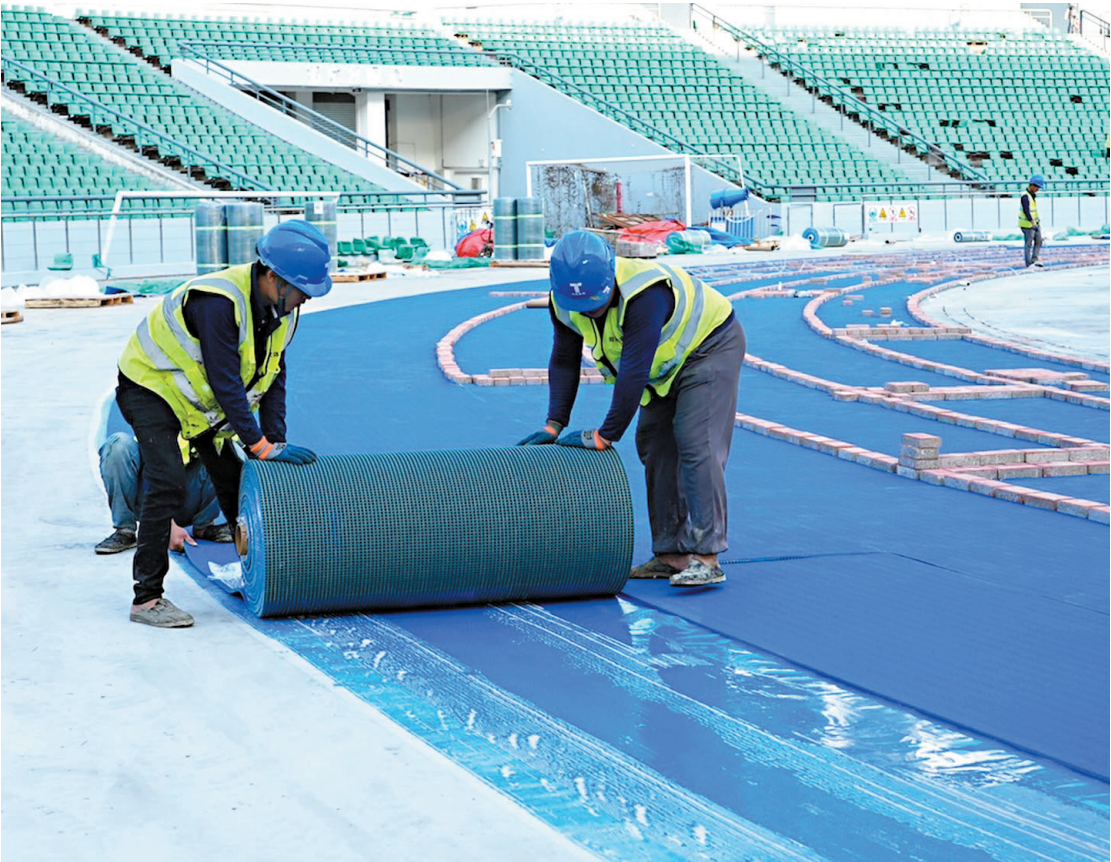
●工人正在廣州大學城體育中心鋪設跑道。
