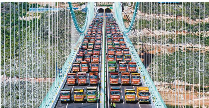
●貴州花江峽谷大橋荷載試驗，在靜力荷載試驗過程中，96輛總重達3,300噸的重型大貨車分批駛上橋面，對大橋進行了一次全面而嚴格的「體能測驗」。新華社
