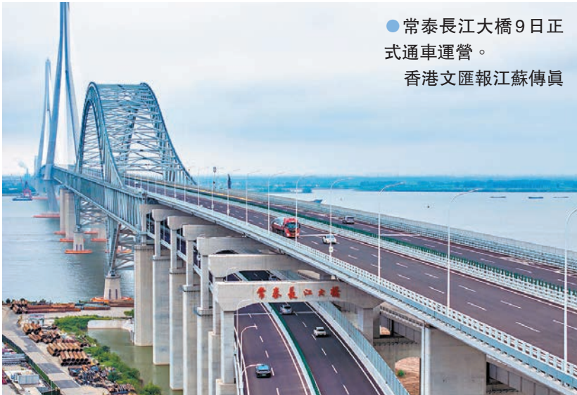
●常泰長江大橋9日正式通車運營。 香港文匯報江蘇傳真 滬陝高速公路（G40），向南經常州高新區樞紐連接江宜高速公路（S39）；下層為雙向四車道，北接泰州泰興市六圩港大道，南接常州新北區滬區大道。 據悉，大橋通車後，常州市、泰州市兩地通行時間將從1小時20分鐘縮短至20分鐘左右。
