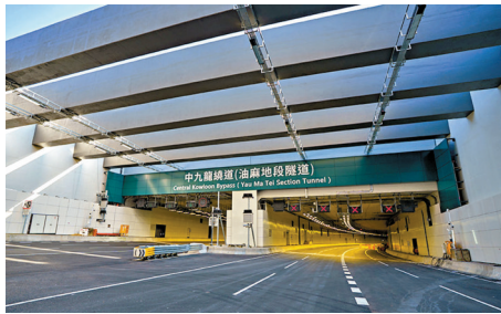
●圖為中九龍繞道(油麻地段隧道)。網誌圖片
