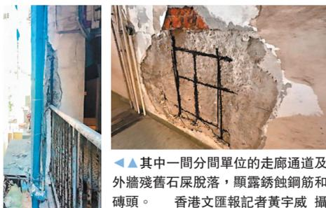
●其中一間分間單位的走廊通道及外牆殘舊石屎脫落，顯露銹蝕鋼筋和磚頭。
