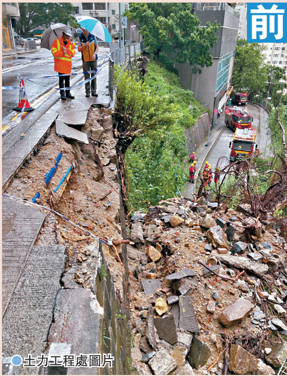
西半山般咸道護土牆加固
