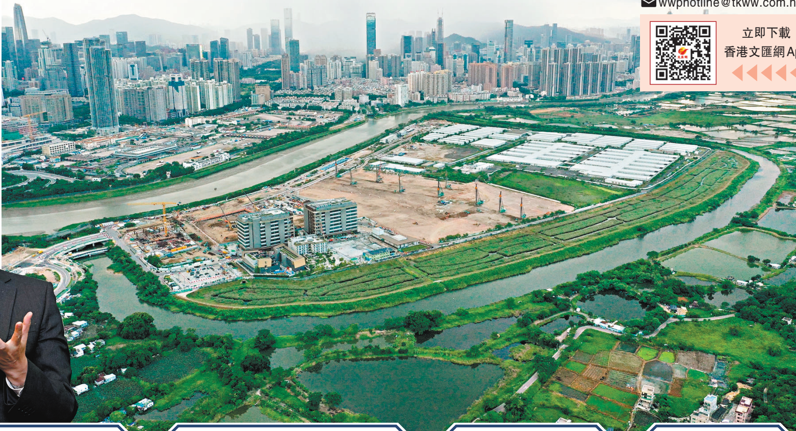
●建設中的河套香港園區。
