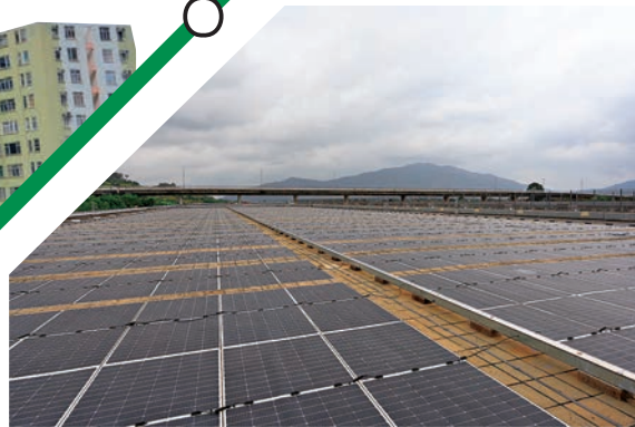
●港鐵八鄉車廠安裝逾2,100塊柔性太陽能板。
