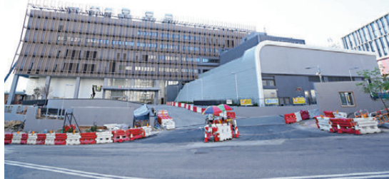
● 香港中醫醫院建設在2025年9月中旬進入收尾階段。
