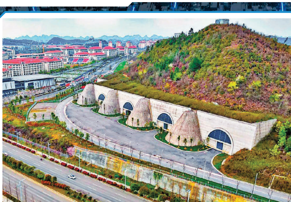
●夯實基礎設施，將數據安全納入「新基建」考核指標體系，建立國家戰略數據災備基地，確保核心和戰略數據在極端情況下的安全與可恢復。圖為貴州貴陽貴安新區騰訊七星洞庫式數據中心。 網上圖片
