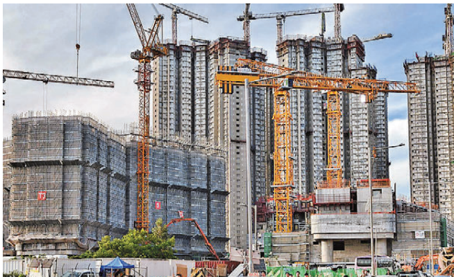
●建造業總工會公布，只有挖掘機工種有人工加。資料圖片
