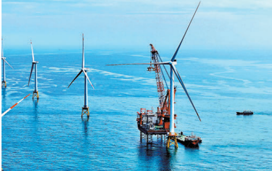
●全球首台16兆瓦海上風電機組在三峡集團福建海上風電場完成吊裝任務。資料圖片
