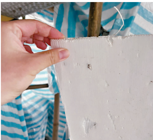
●承建商疑用發泡膠封窗。
