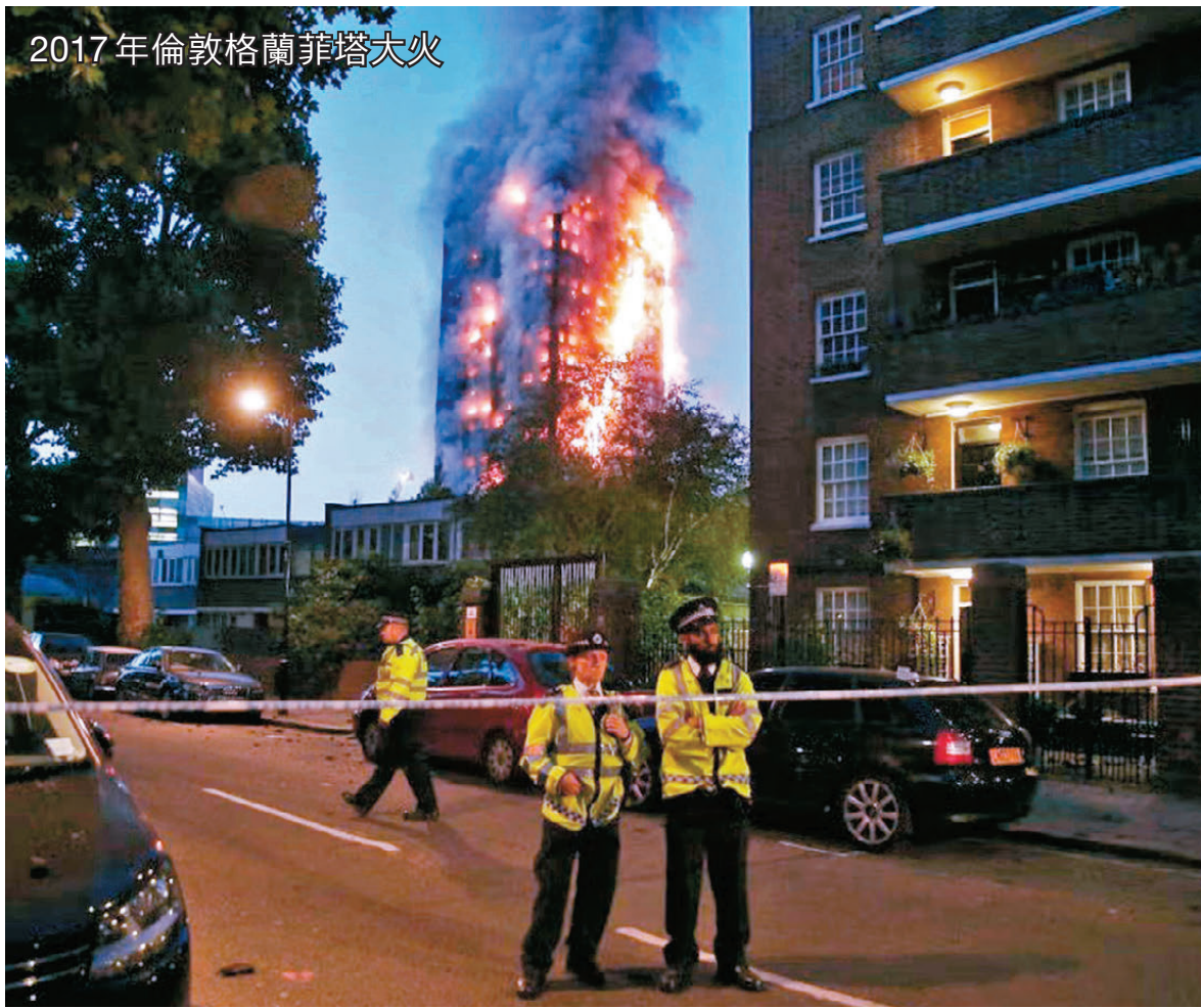
●外媒報道宏福苑火勢與倫敦格蘭菲塔大火相似，起火建築外圍的大量易燃材料加劇火勢。 網上圖片
