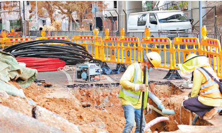
▲中電工程人員昨日重新鋪設地底電纜。
