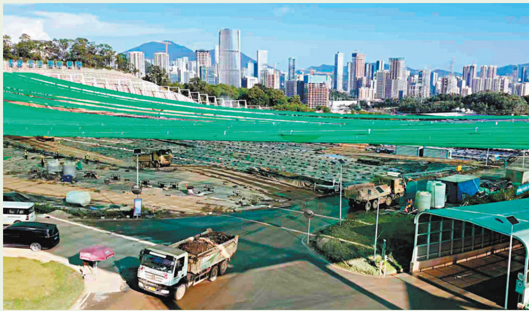
●作為全國體量最大、唯一身處中心城區的簡易垃圾填埋場，深圳市羅湖區玉龍垃圾填埋場計劃完成逾255萬立方米陳腐垃圾治理。
