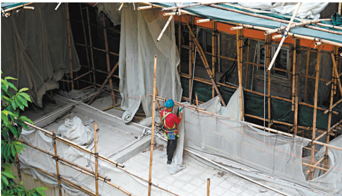
●發展局早前公布監管外牆棚網新制度。圖為工人拆除外牆棚網。
