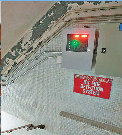
圖為中西區新街10號的樓宇，內部設置了物聯網火警偵測系統，以及更新了滅火筒等消防設備。
