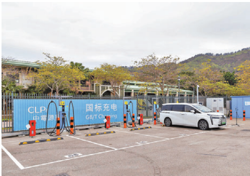
▲圖為中電源動力位於竹篙灣的電動車充電站，站內分別設有國標及歐標充電設施。
