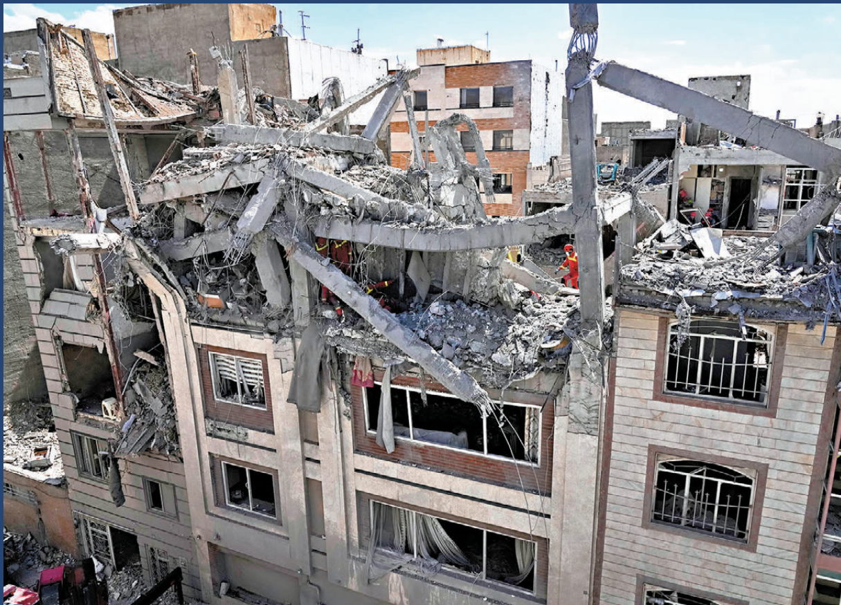
德黑蘭一棟住宅大樓早前在空襲中受損。
