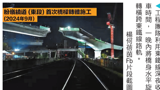
▲工程團隊利用東鐵線深夜收車時間，一晚上將橋身水平旋轉橫跨東鐵線路軌。 楊何蓓茵 Fb 片段截圖
