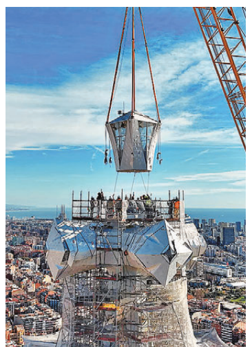
十字架上臂吊裝到位的一刻。
