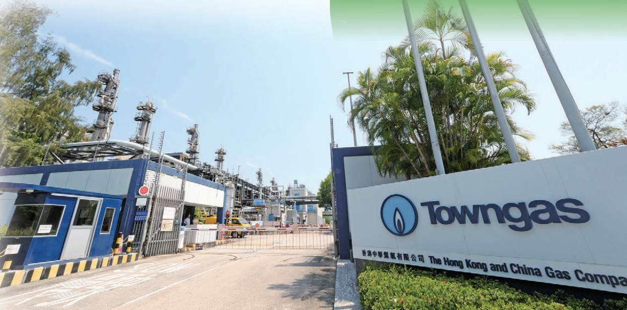
●位於大埔的製氣廠是Towngas的主要生產基地。現時全港地底管網輸送的燃氣中，約有一半成分為氫氣，這龐大的管網為香港未來廣泛應用氫能奠定了穩固的基礎。
