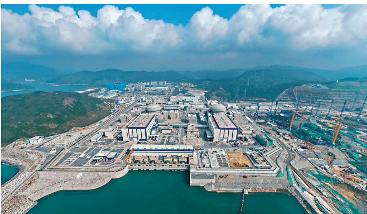
●4月20日，粵港澳大灣區首台「華龍一號」核電機組投產發電，正式具備商業運行條件。圖為20日拍攝的中廣核廣東太平嶺核電項目。
