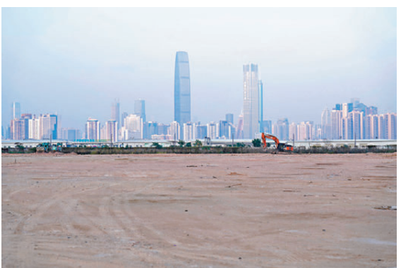
●北都會區多塊土地平整和基建工程已如火如荼。圖為港深創科園土地平整區。
