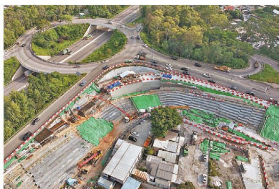
●元朗十八鄉路交匯處興建往元朗公路分支路的路堤 建造工程採用「高延性輕質複合混凝土」後， 整體施工時間縮短約四五成。網誌圖片 的「風洞實驗室」，為隔音屏障設計參數尋求更 精準的科學依據，元朗南第二期發展項目便有效 降低約20%隔音屏障的工程成本。
