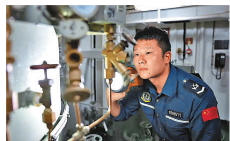
●4月26日，海警川山艦執法員梁劍睿在機艙內巡檢設備。
