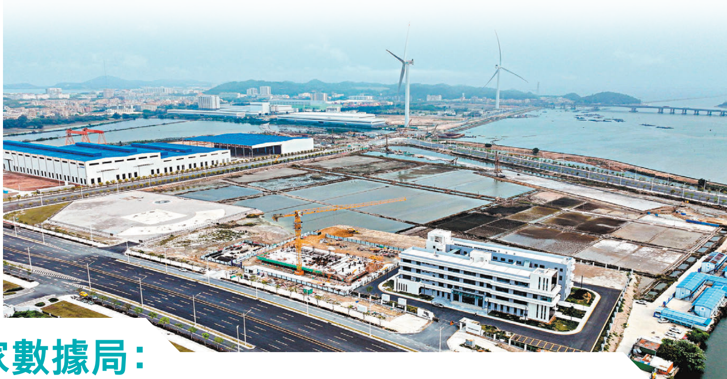
●廣東省風電臨海試驗基地試驗樓近期投產建成。遠處是該基地正在測試風機的1、2號大容量海上風機測試機。
