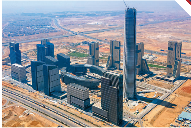
●由中國建築股份有限公司埃及分公司承建的埃及新行政首都中央商務區項目。網上圖片
