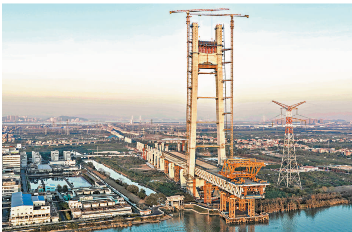
●合湛高鐵路將連接深湛高鐵路等線路。圖為深湛高鐵路深江段建設現場。 香港文匯報廣東傳真
