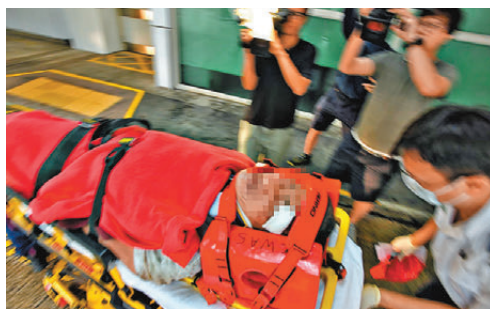
●在柴灣水務署總部大樓地盤3樓工作平台踏空跌落2樓受傷的工人送院治理。
