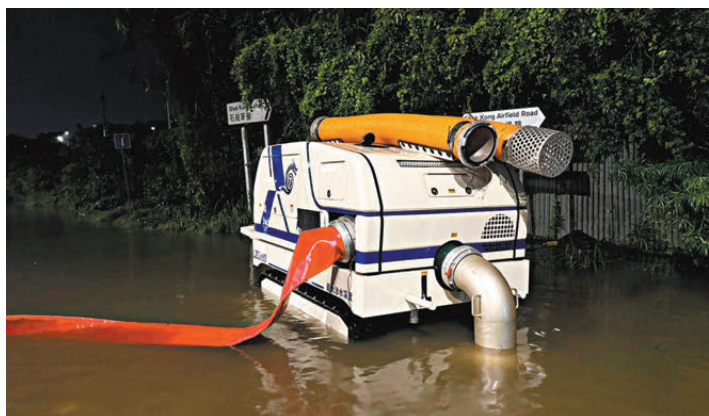
●排水機械人「龍吸水」在石崗機場路協助處理水浸。 Fb 圖片
