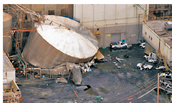
●裝載「白液」的儲存缸破裂，令多名工人遭受化學灼傷。路透社
