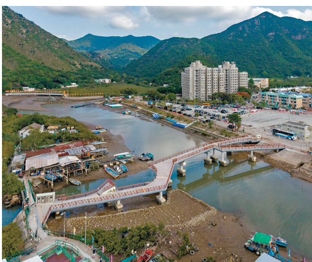
▲大澳鹽田橋是香港首條採用伸縮式開合設計的行人橋，連接龍盛街及新基街河涌兩岸。甯漢豪網誌圖片
