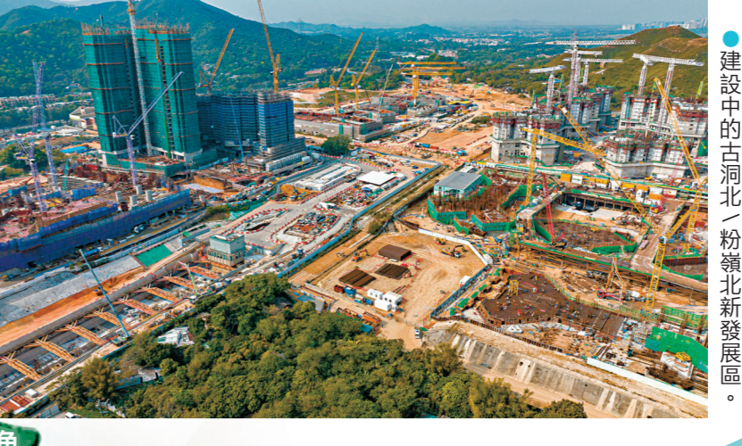
●建設中的古洞北粉嶺北新發展區。
